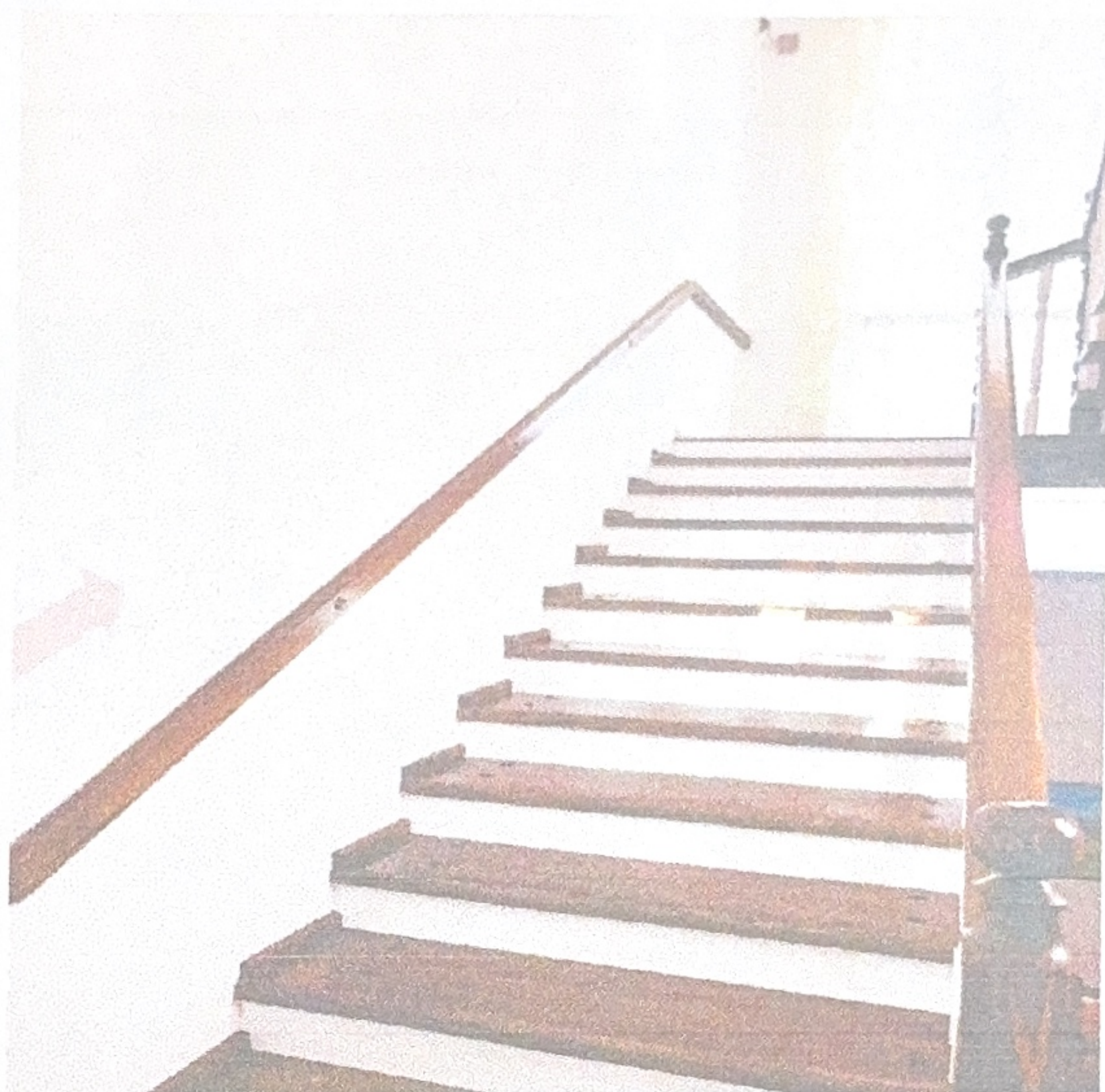
Вход №1. Лестничный проем на 3 этаж
